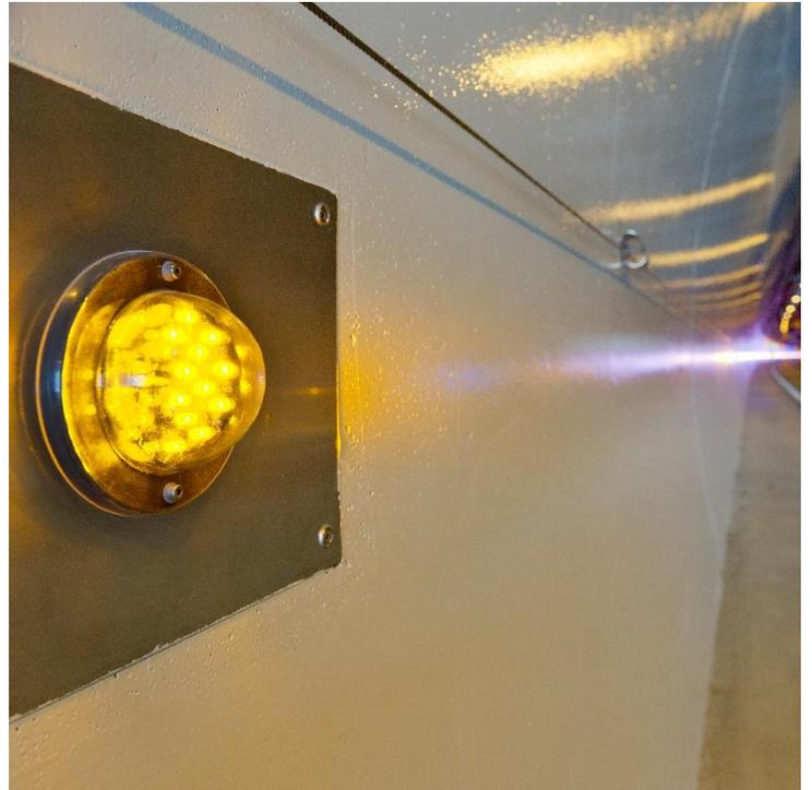
**Plot de jalonnement LED** étanche IP67 pour le balisage de sécurité des tunnels routiers et autoroutiers. Ces Balises LED permettent d'indiquer la distance de sécurité à respecter pour les automobilistes.
