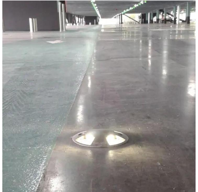
**Balise LED NOVA** de sécurité 45lm quadri-directionnelle réalisée en inox 316L et polycarbonate antichoc pour résister aux passages des véhicules
