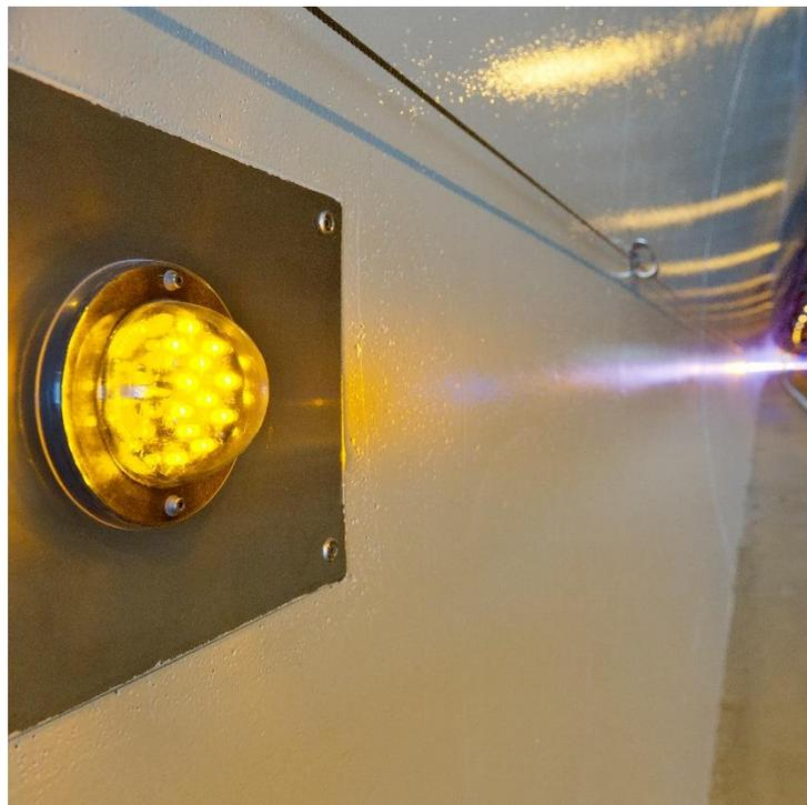
**Plot de jalonnement LED étanche IP67** pour le balisage de sécurité des tunnels routiers et autoroutiers. Ces Balises LED permettent d'indiquer la distance de sécurité à respecter pour les automobilistes.
